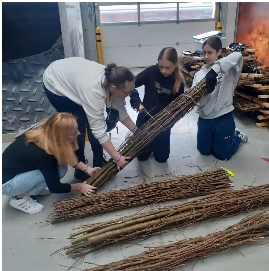
Fot. 4. Przygotowanie wiązek faszyny – elementu konstrukcji (źródło: H2O SCITECH)
