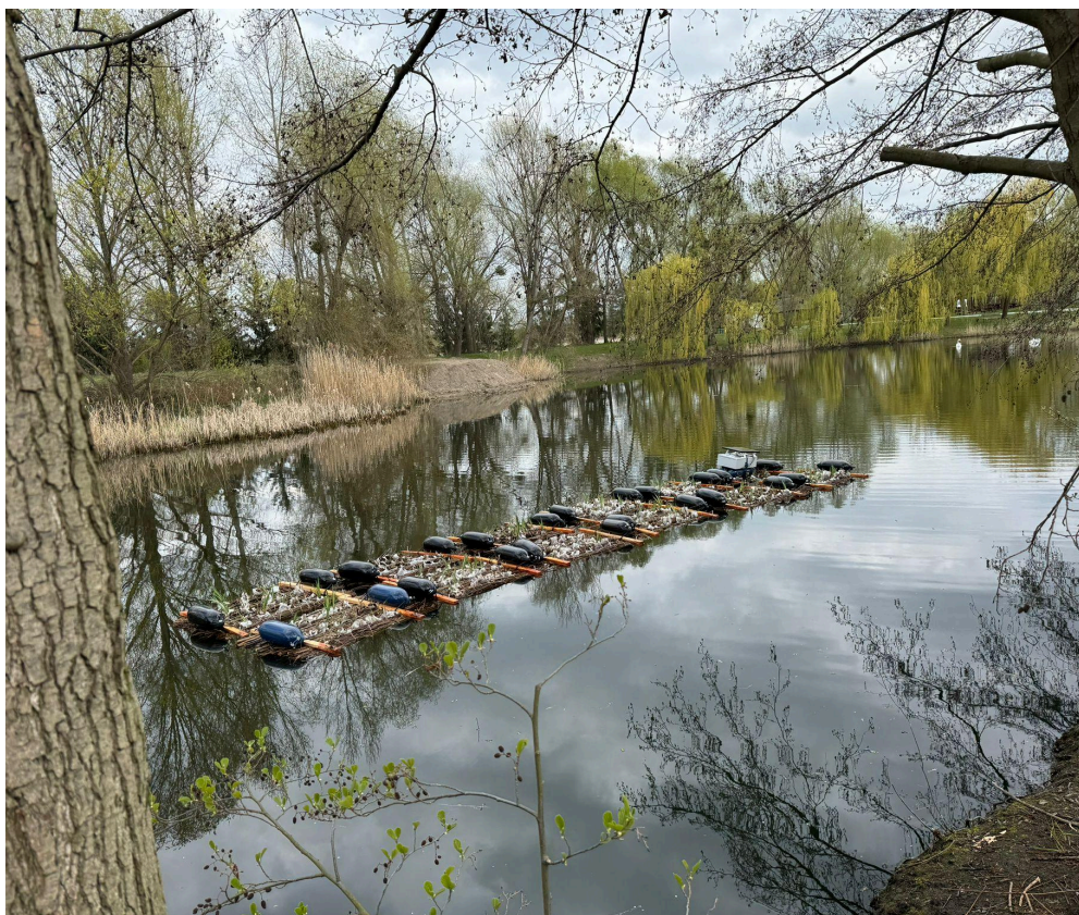
Fot. 9. Dwanaście zwodowanych roślinnych wysp filtracyjnych (źródło: H2O SCITECH)
