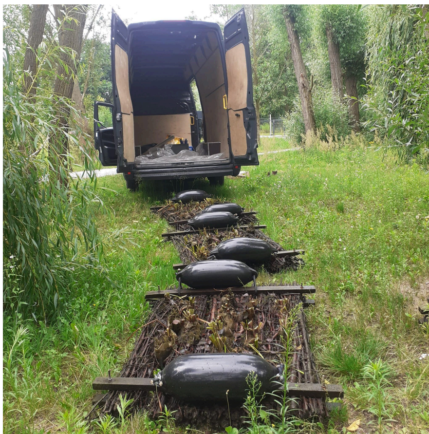
Fot. 12. Zebrane wyspy filtracyjne po ścięciu roślin (źródło: H2O SCITECH)
