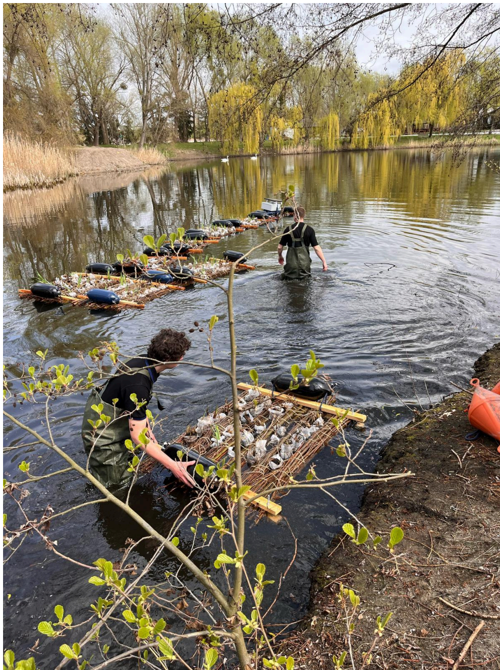
Fot. 8. Proces wodowania i cumowania wysp (źródło: H2O SCITECH)
