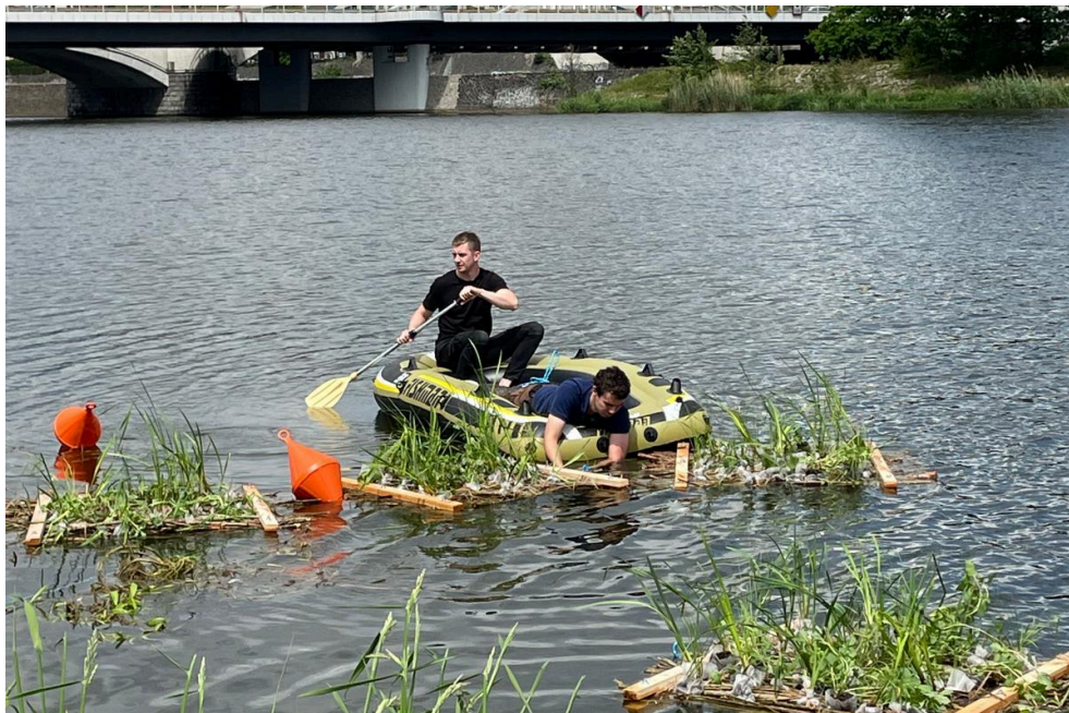
Fot. 6. Łączenie i cumowanie roślinnych wysp filtracyjnych (źródło: H2O SCITECH)
